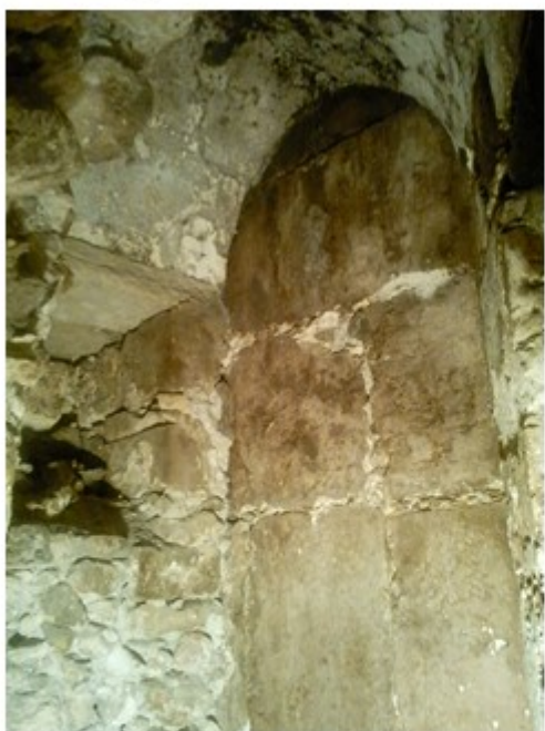
Υπόγεια κρύπτη (κελί) κάτωθεν της εκκλησίας του Αγίου Κωνσταντίνου, κατασκευασμένο σε επαφή με το εξωτερικό τύμπανο της ροτόντας. Είναι εμφανές το σφραγισμα του παραθύρου που είχε θέα μέσα στην ροτόντα.
