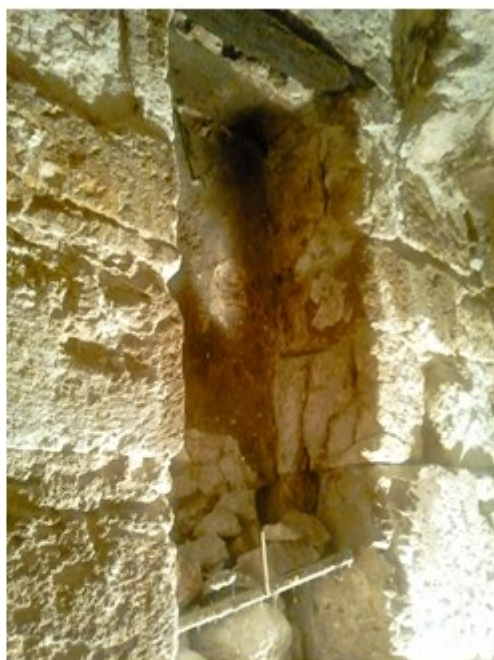
Υπόγεια κρύπτη (κελί) κάτωθεν της εκκλησίας του Αγίου Κωνσταντίνου, κατασκευασμένο σε επαφή με το εξωτερικό τύμπανο της ροτόντας. Είναι εμφανές το σφραγισμα του παραθύρου που είχε θέα μέσα στην ροτόντα.
