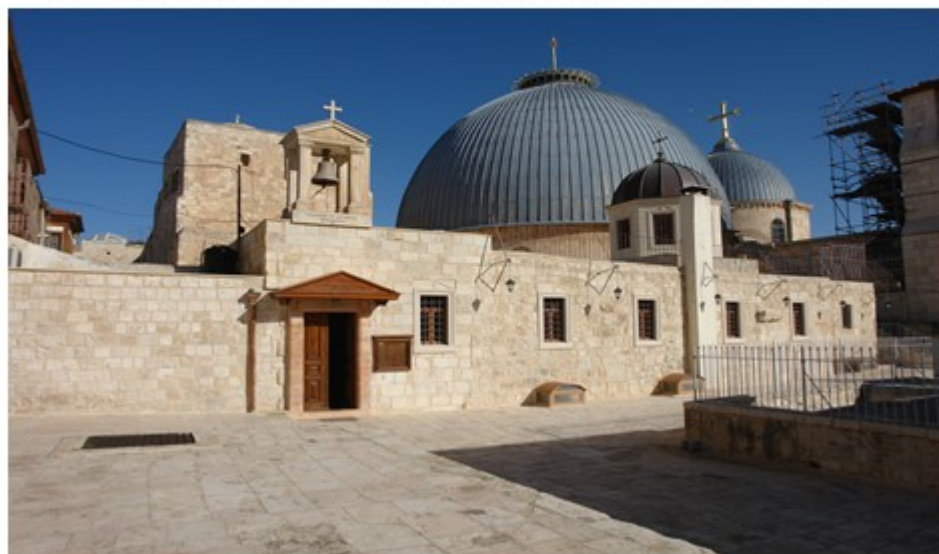
Ι.Ν. του Αγίου Κωνσταντίνου - Μετά την ολοκλήρωση της επέμβασης το 2013
